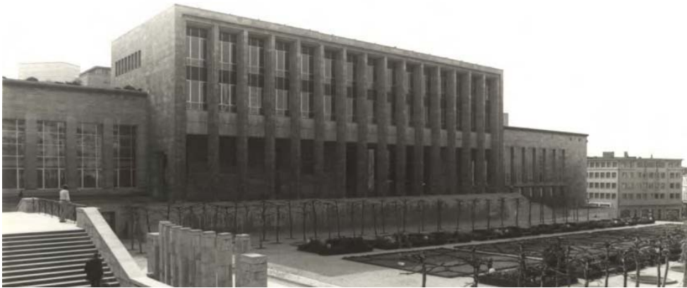
101: voorgevel van de gerealiseerde Albertina-bibliotheek met het verhoogde toegangsportiek en de laterale trappenpartij die uitmondt aan de voet van de Kunstberg (bron: Sint-Lukasarchief Brussel)
