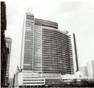
119: Internationaal Rogier Centrum , oostelijke gevel vanuit de Ginestraat, s.d. (bron: www.irismonument.be )
