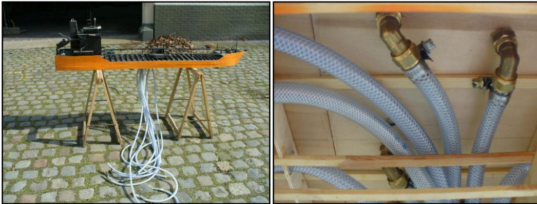
Foto's 60 en 61 - De versterkte soepele slangen. Bochtstukken met schroefdraad.
