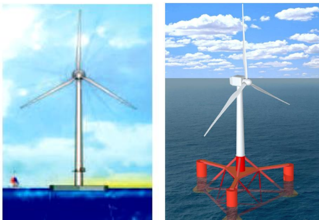
figuur 18 Barge-concept [13] en Triple floater (gekozen concept in Nederlands onderzoek) [8]
