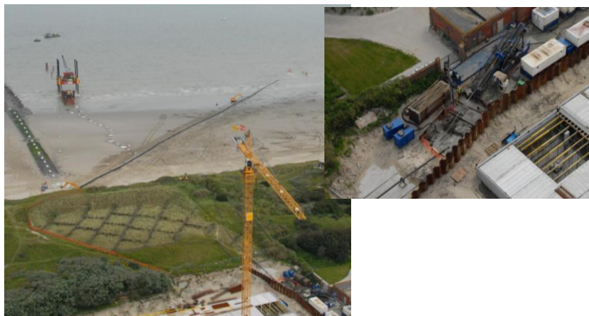
figuur 98 Overzicht van de gestuurde boring en detail van de boorinstallatie (onder rechts) [77] (De HDPE-buis bevindt zich hier nog op het strand.)
