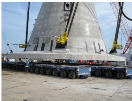
figuur 80 Ophijsen GBF van de SPMT-configuratie [18]
