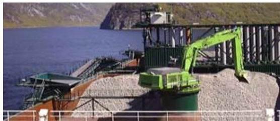
figuur 76 Valpijpschip Seahorse gebruikt bij het Thorntonproject : detail van de laadkraan die het materiaal overbrengt in de hopper (links) waarna de stenen op de transportband worden gestort (links) [40]
