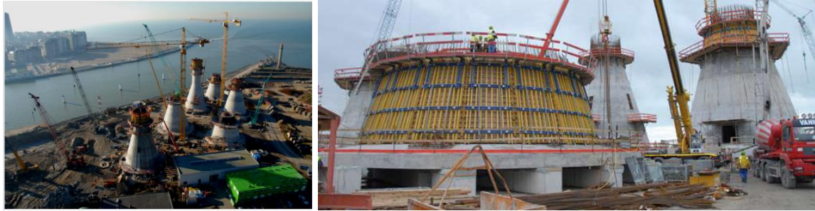
figuur 79 Gravity Based Foundations van fase 1 in constructie op de 'Halve Maan'-site [18], [44]
