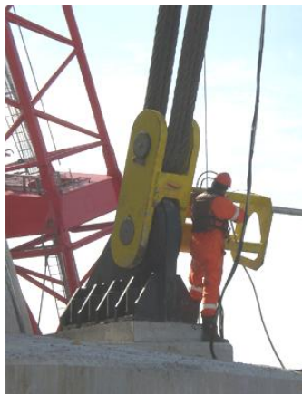
figuur 82 Hydraulische sluiting gekoppeld aan de lifting lug op de basis van de GBF [80]
