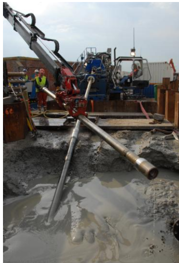
figuur 99 Boorwerken op 01/08/07: de juiste helling van de boorinstallatie (blauw) wordt bekomen door diens platform te hellen [77]
