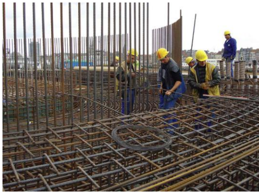
figuur 129 De GBF's voor de Thorntonbank zijn opgebouwd met een grote hoeveelheid staal [54]
