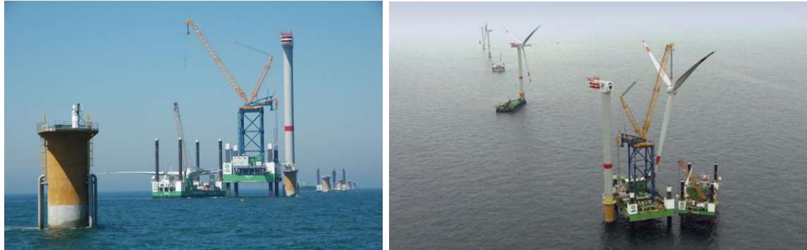
figuur 125 Oprichting van de windturbines op de Thorntonbank [101], [82]
