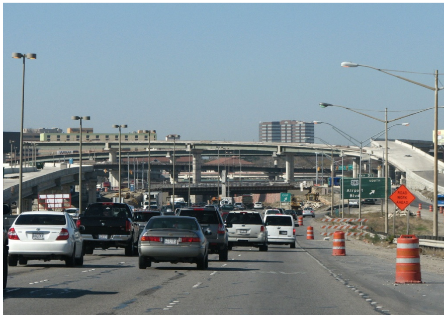
Figuur 68 - Zijdelings zicht op SH 121 Freeway in Dallas (Texas) (foto: www.aaroads.com )
