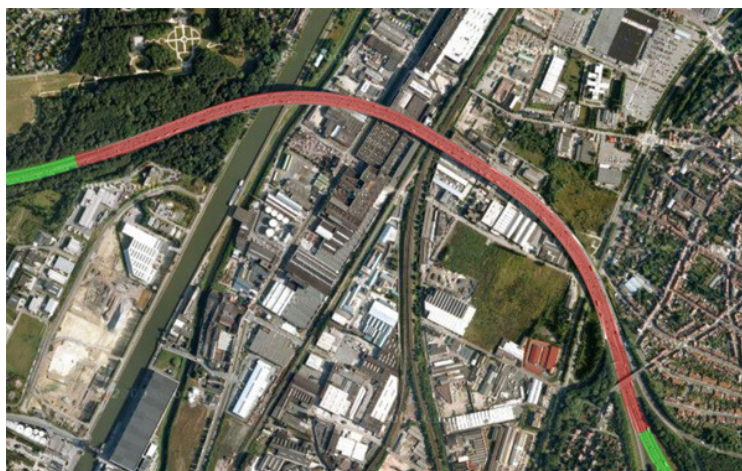
Figuur 56 - Luchtfoto viaduct van Vilvoorde (foto: Google)
