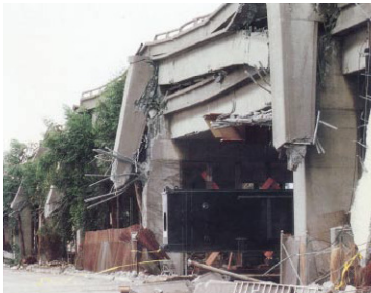
Figuur 74 - Ingestort dubbeldek van de Nimitz Freeway in Oakland (VS)
