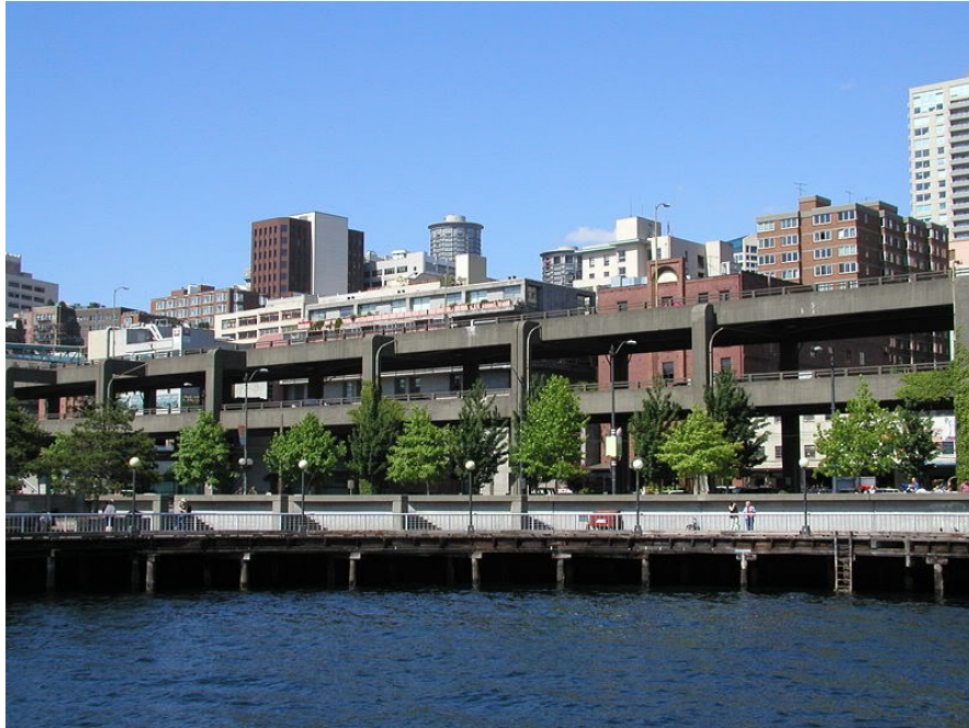
Figuur 69 - Zijdelings zicht op Alaskan Way Viaduct in Seattle, Washington (VS)
