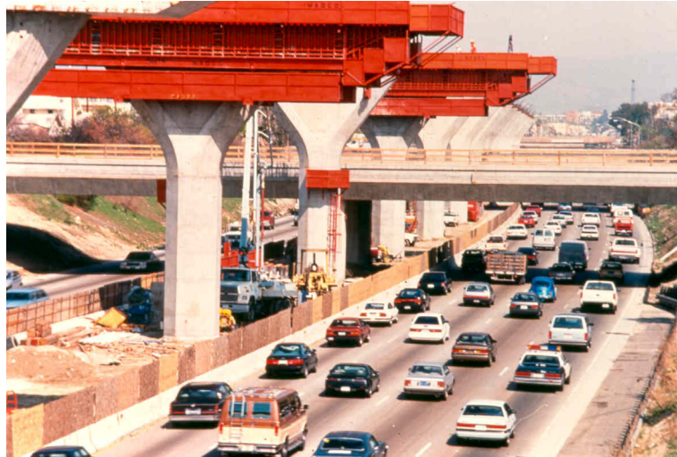
Figuur 32 - Uitwerken pijlers bij Los Angeles Freeway (VS)
