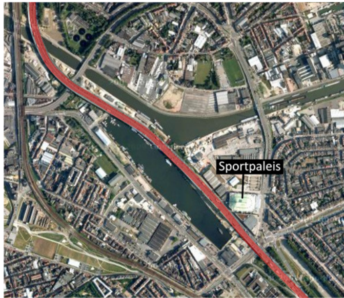
Figuur 44 - Luchtfoto viaduct Merksem (foto: Google)
