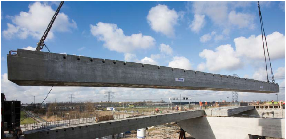
Figuur 33 - Plaatsen van kokerbalk (foto: Haitsma Beton Nederland)
