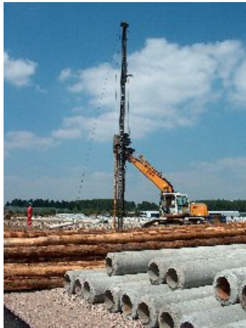
Figuur 31 - Uitvoering paalfundering (foto: De Kuiper Heiwerken b.v.)
