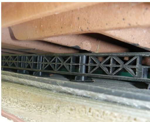
Figuur 2.24: Ventilerende onderlat
