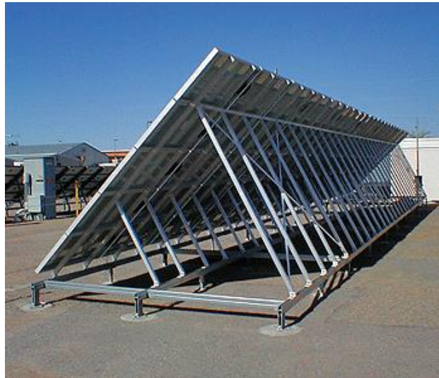
Figuur 1.20: Bevestiging van zonnepanelen op een plat
