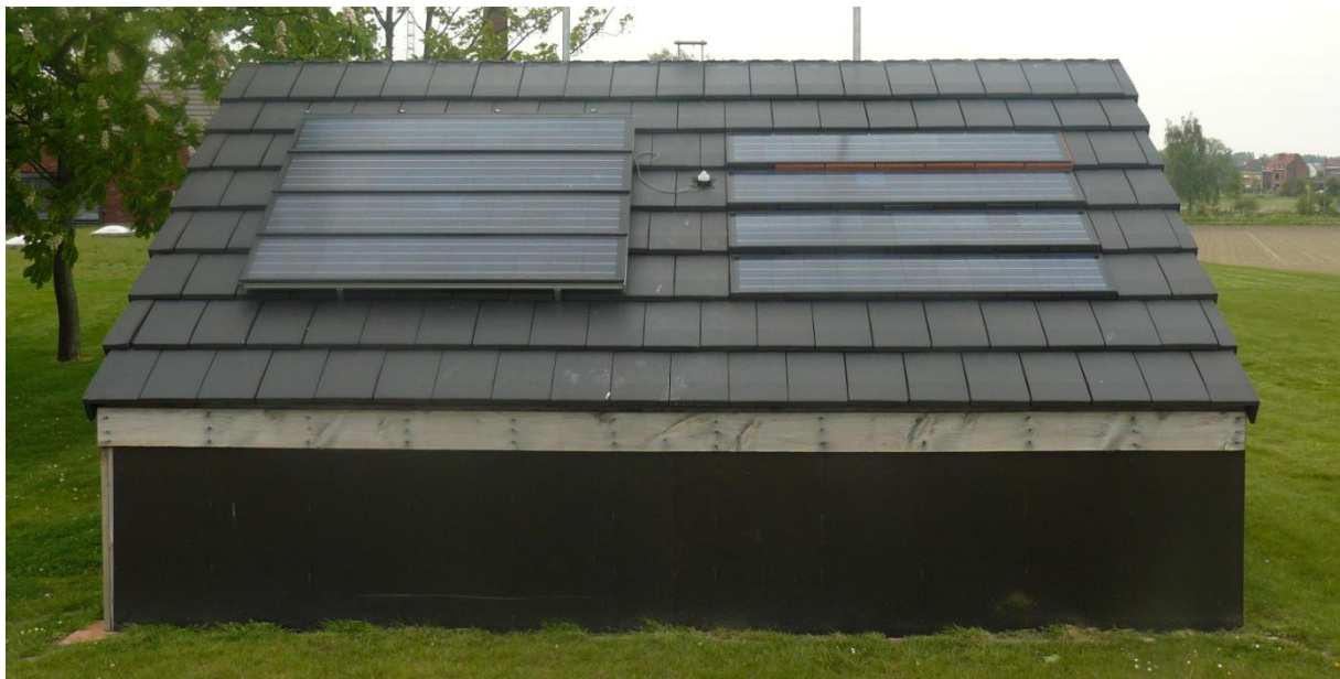
Figuur 2.23: Testdak met verschillende systemen
