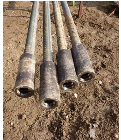
Figuur 8.8 De ankers worden neergelaten in de buitenstangen en onderling gekoppeld door moffen
