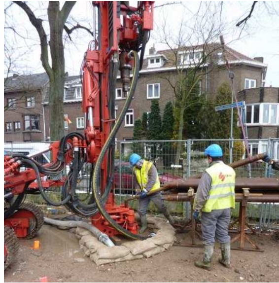
Figuur 8.5 Het koppelen van de verschillende stangen
