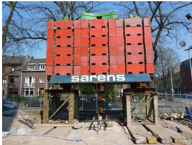
Figuur 8.21 De statische belasting bij de nieuwe proef op de VHP-LR paal
