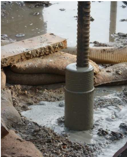
Figuur 8.8 De ankers worden neergelaten in de buitenstangen en onderling gekoppeld door moffen
