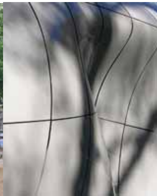
095 - De gevel van het kabelbaanproject
