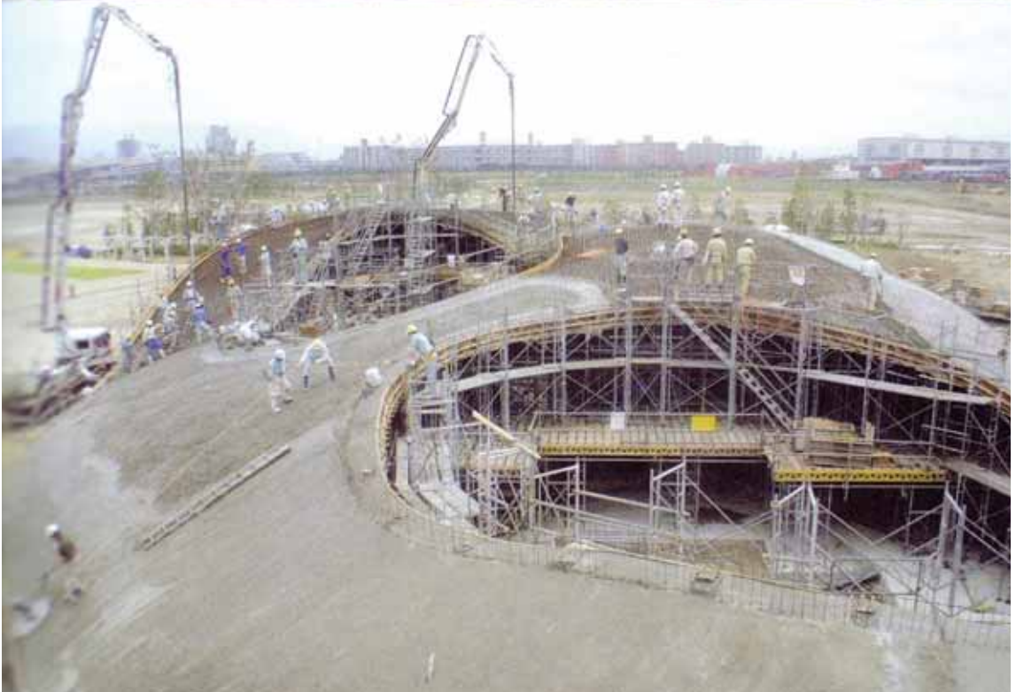
061- Het Grin Grin complex in opbouw, een arbeidsintensief bouwproces
