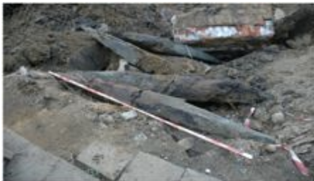
Fig. 3: Houten palen waarop de funderingen van de burchtmuur rustten.
