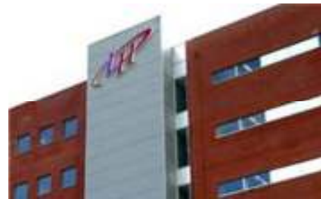
Figuur 4: Gebouw L&H in Leper
