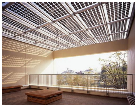
Figuur 23: Transparante panelen in een dak [101]
