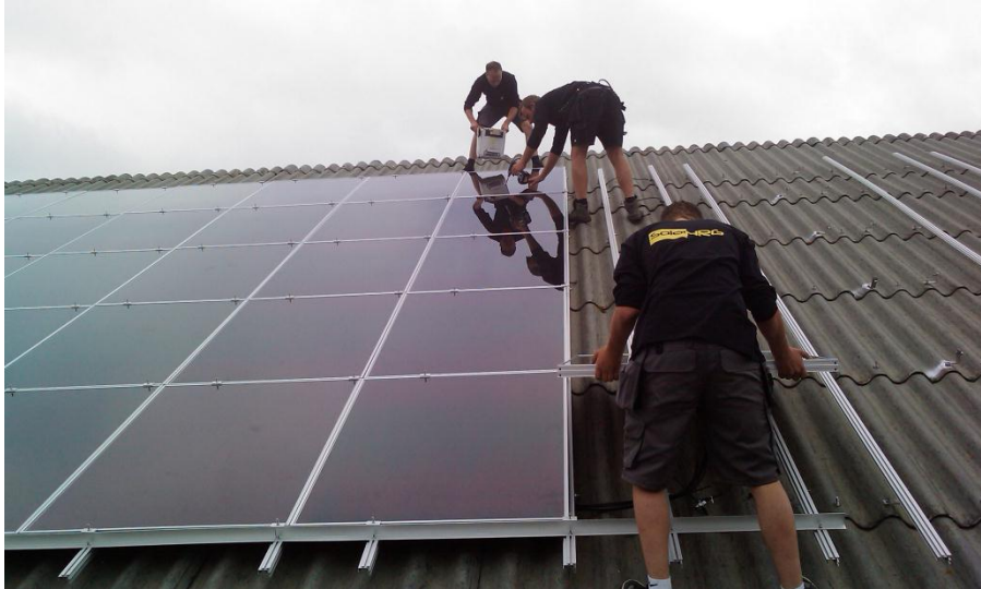
Figuur 18: Installatie met frame op hellend dak [17]
