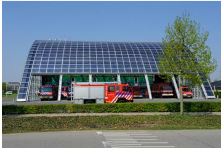
Figuur 20: Geïntegreerde zonnepanelen op brandweerkazerne Utrecht [19]
