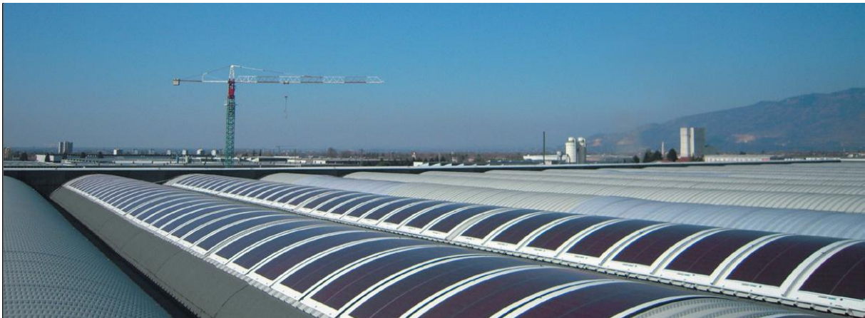
Figuur 3: Toepassing van amorfe zonnecellen op het dak van een industrieloos [96]
