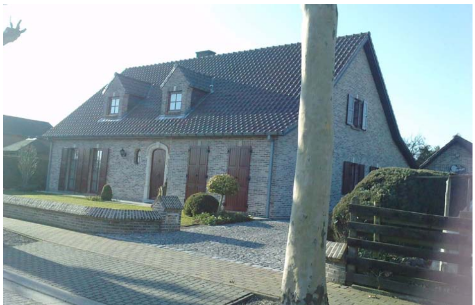
Afbeelding 3.4.22: Bij deze fermette zijn de raamopeningen tot aan de vloer doorgetrokken
