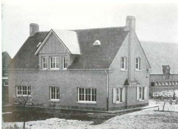
Vernieuwde boerenwoning in de Polder, naar de op- vatting van «Het huis onzer dromen».
