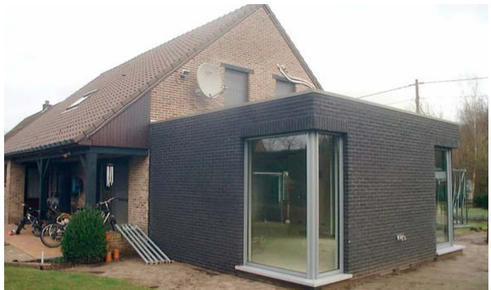
Afbeelding 5.4.2.5: De fermette na de aanbouw
