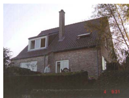
Afbeelding 5.4.4.11: De voorgevel voor de verbouwing
