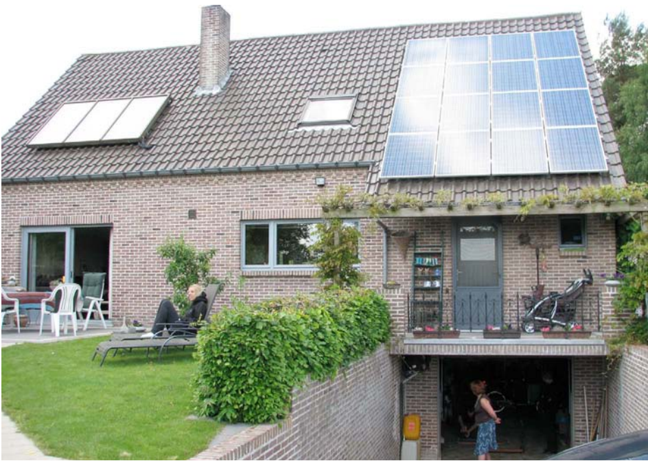
Afbeeldingen 5.5.3: Zonnepanelen en zonneboilers vinden hun weg naar het dak van de fermette
