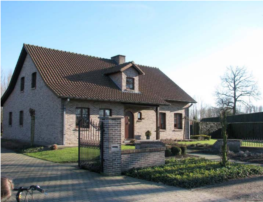
Afbeelding 3.4.26: De rollaag in boogvorm dient als sierelement, de dorpel wordt in gevelsteen voorzien
