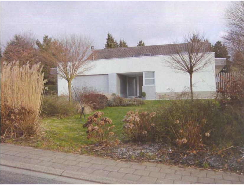
Afbeelding 5.4.4.27: De nieuwe voorgevel van de woning
