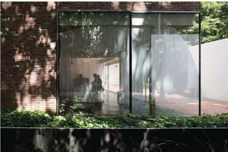
Afbeelding 5.4.4.41: De vensters zijn hoger dan de hoogte van de binnenruimte
