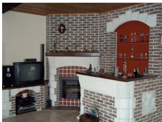
Afbeelding 3.5.4: Ook een huiselijk toegje wordt in zichtbaar metselwerk opgetrokken
