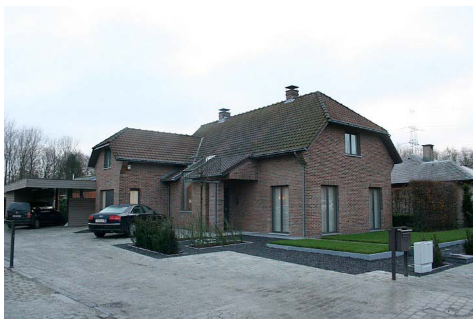
Afbeelding 5.2.15: De voorgevel na de ingreep
