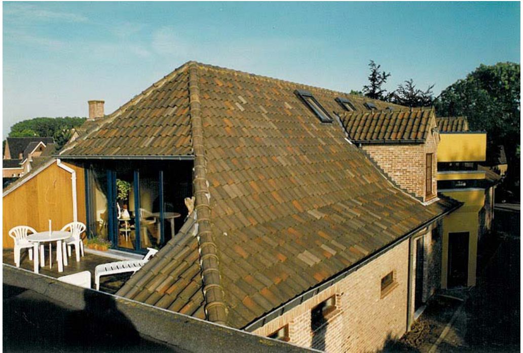
Afbeelding 5.4.3.11: Een deel van het dak werd afgebroken voor een dakterras
