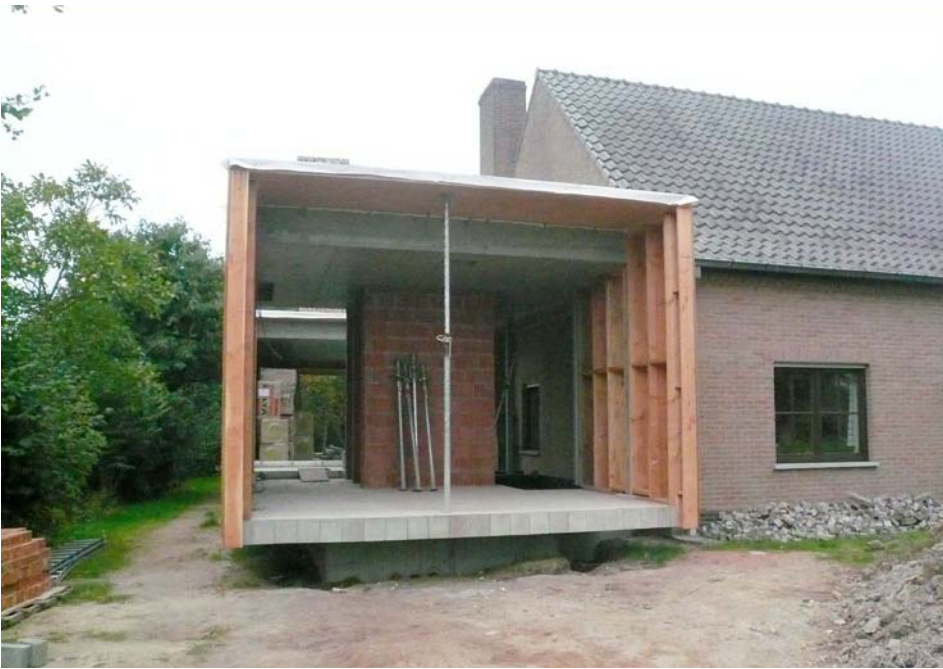
Afbeelding 5.4.2.12: Het nieuwe volume in uitvoering
