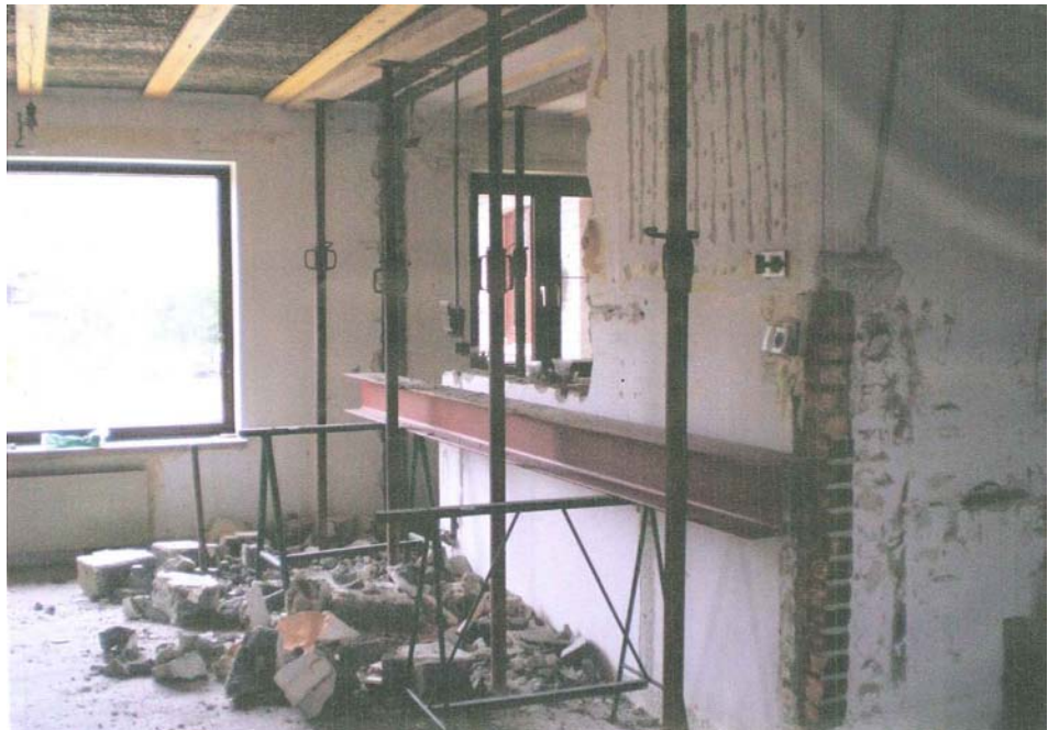
Afbeelding 5.2.2: De muur tussen de keuken en living wordt gesloopt met het oog op een open keuken
