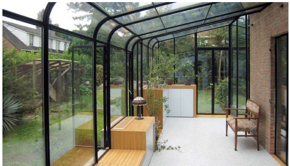
Afbeeldingen 5.3.9 tot 5.3.11: Additie Wintertuin door Plus Office Architects
