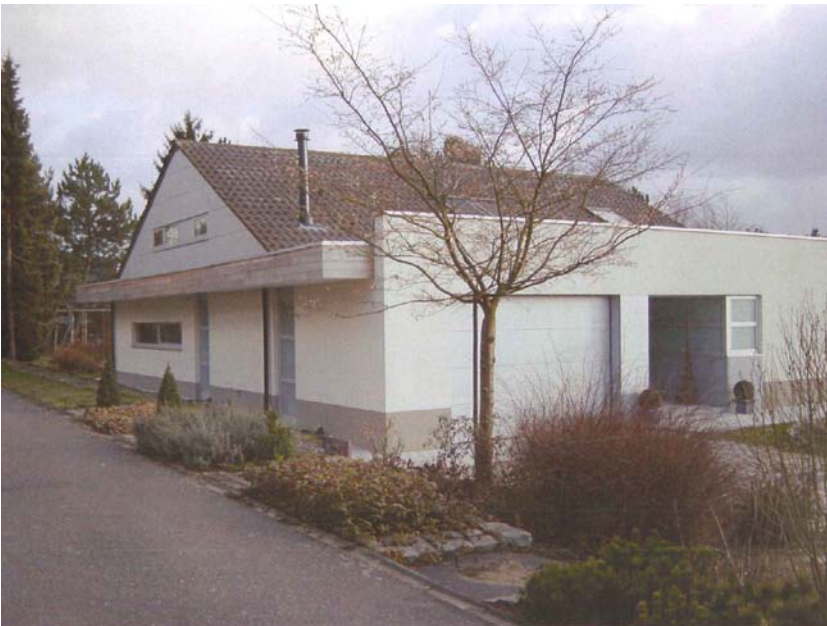
Afbeelding 5.4.4.28: De nieuwe zijgevel van de woning
