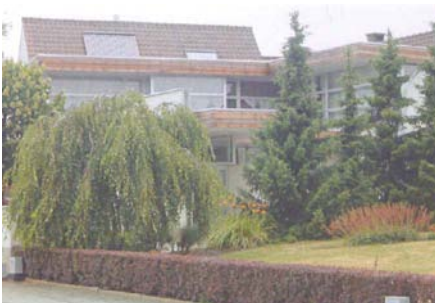
Afbeelding 5.4.4.15: De hele achtergevel wordt opengetrokken
