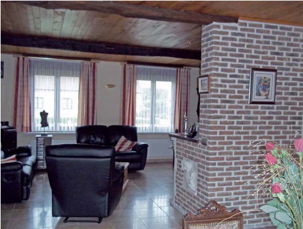
Afbeelding 3.5.7: : Het plafond met eiken balkjes zonder dragende functie
