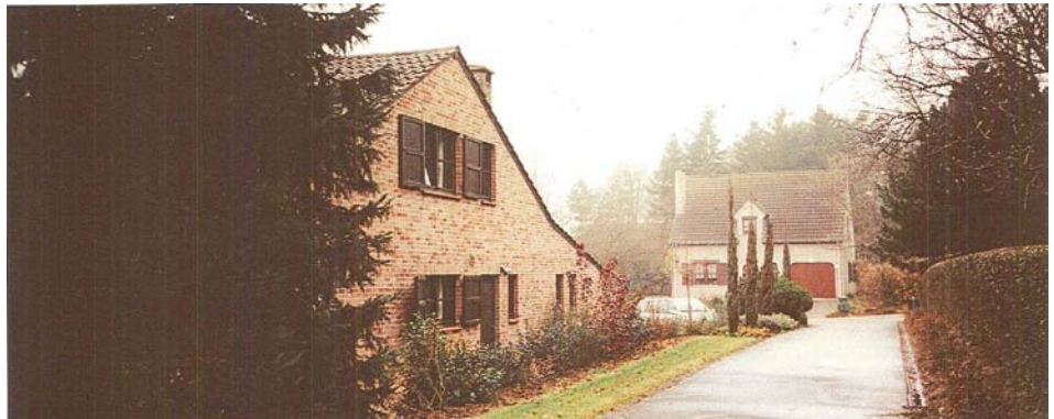
Afbeelding 5.4.4.22: De zijgevel van de fermette voor de verbouwing
