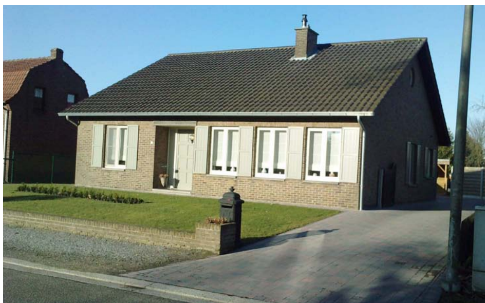
Afbeelding 3.4.32: De luikjes zijn onvoldoende om alle vensters te bedekken
