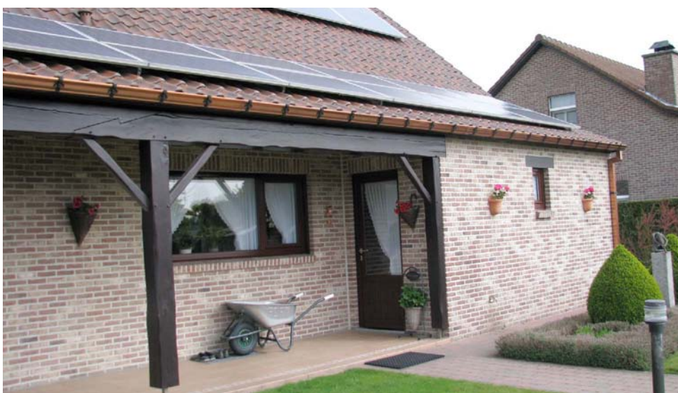
Afbeelding 3.4.20: 'Oude' eiken balken ter ondersteuning van de dakoversteek
