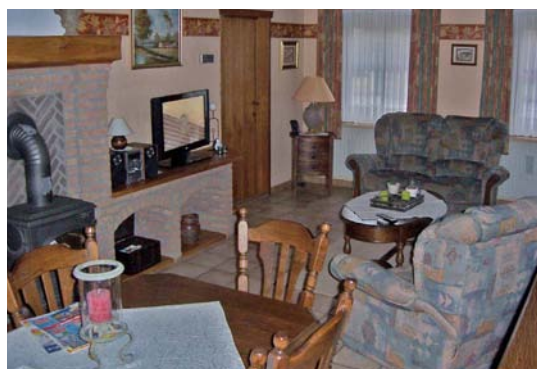
Afbeelding 3.5.3: Het zichtbaar metselwerk van de schouw wordt doorgetrokken in een tableau voor de televisie
