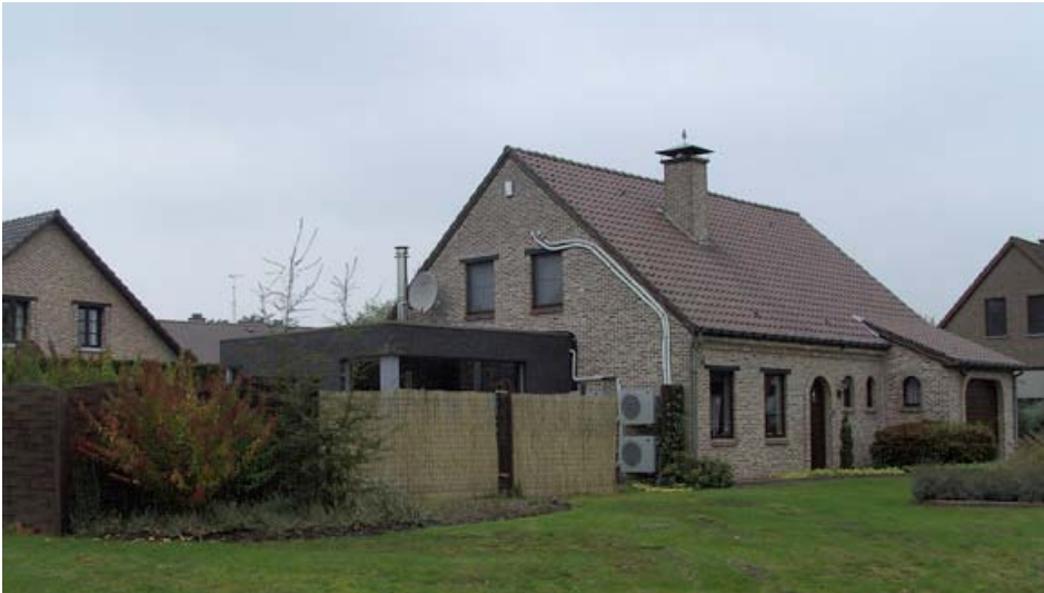
Afbeelding 5.4.2.6: De woning bevindt zich op een hoekperceel
