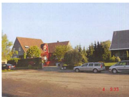
Afbeelding 5.4.4.10: De fermette voor de verbouwing
