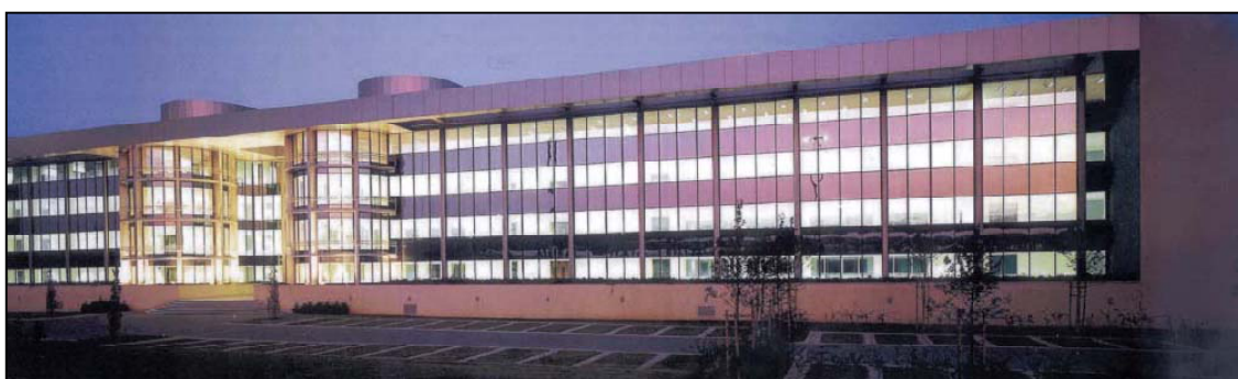
Figuur 5-18: Het Cores-gebouw
