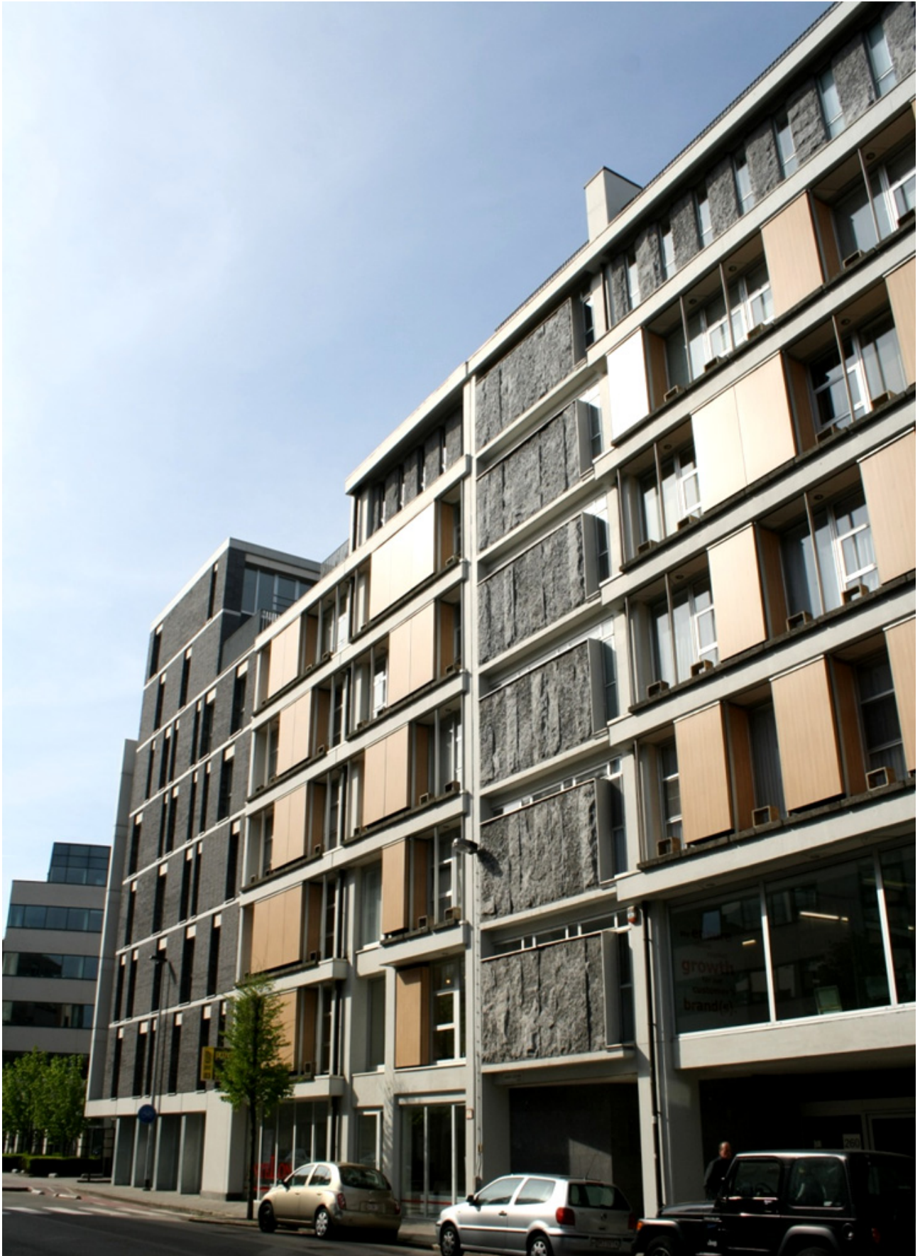
Afbeelding 27: Voorgevel HBK, van rechts naar links: oorspronkelijk ontwerp, eerste en tweede uitbreiding Bron: eigen foto, 2011
