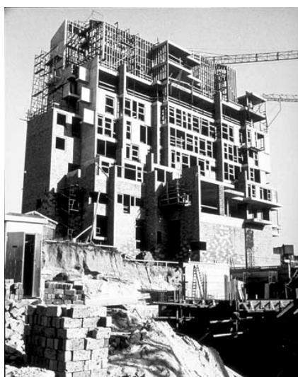
Afbeelding 38, 39, 40: Werffoto's, les granges bovenop de promenade van kolommen en metselwerk wanden Bron: Atelier Kroll, via HTTP://HOMEUSERS.BRUTELE.BE/KROLL/
