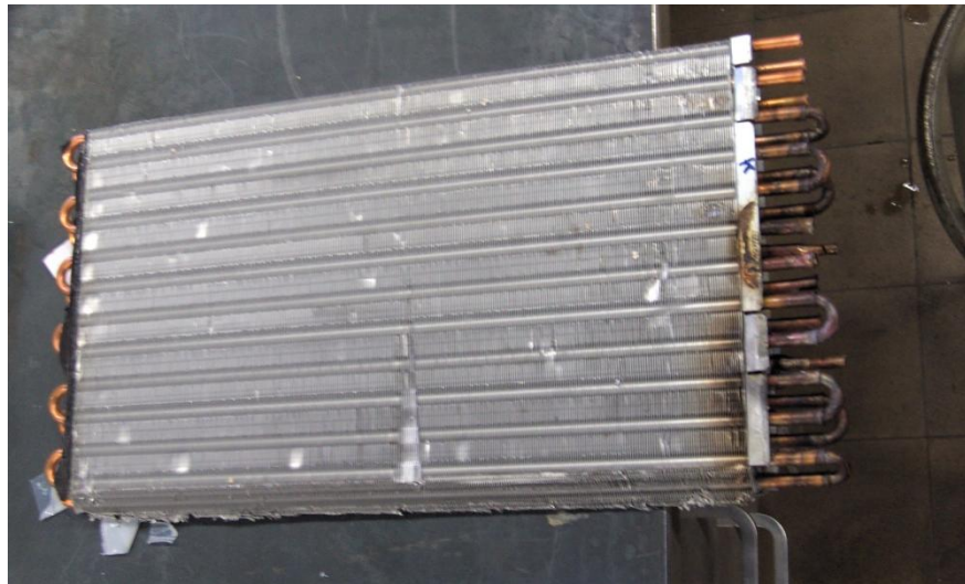
Figuur 56 - Warmtewisselaar met adapted inclined louvered fins (Daikin)
