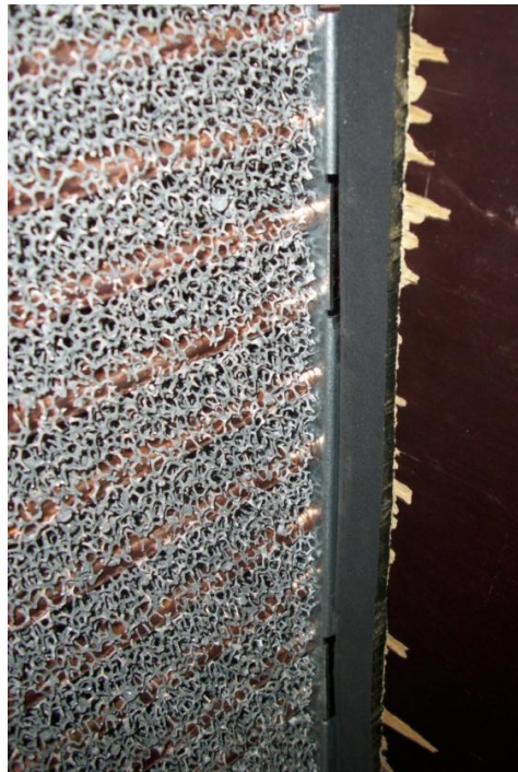
Figuur 68 - Afdichting aan luchtzijde met rubberen strips
