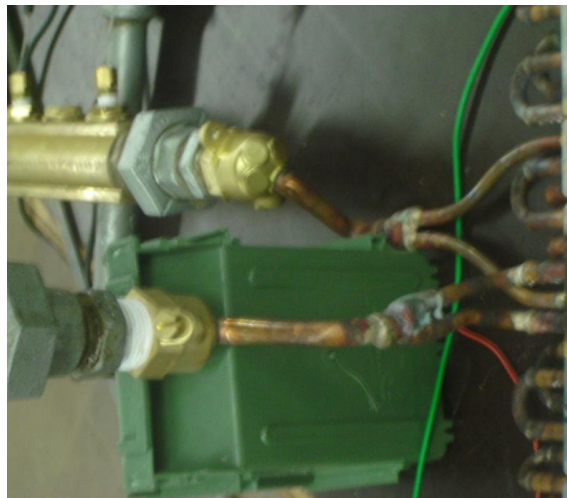
Figuur 87 - Illustratie van de aansluiting voor de warmtewisselaar
