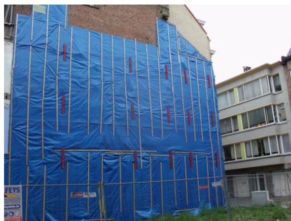
Figuur 63: Toepassing speldankers
