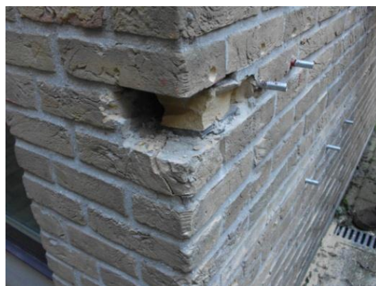
Figuur 113: Na verwijdering metselwerk
