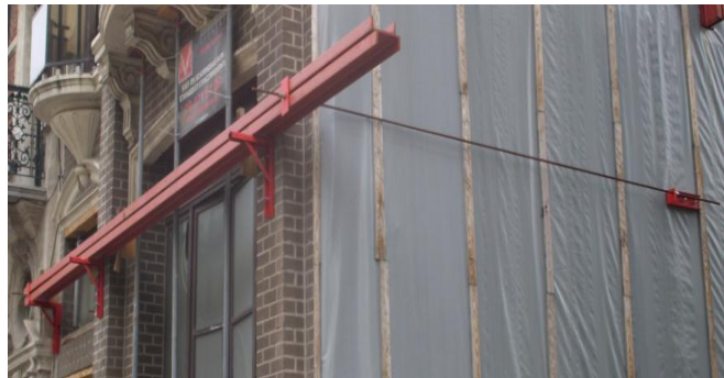
Figuur 18: Verankering in voorgevel
