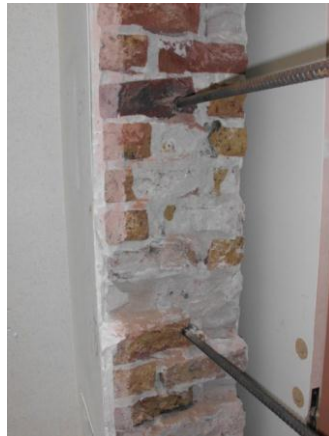
Figuur 103: Weergave stangen in metselwerk
