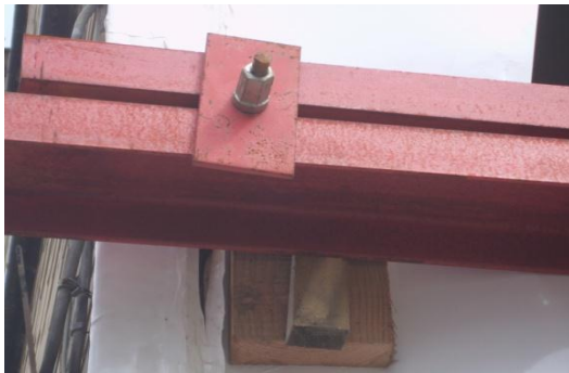
Figuur 17: Verankering in scheidingsmuur
