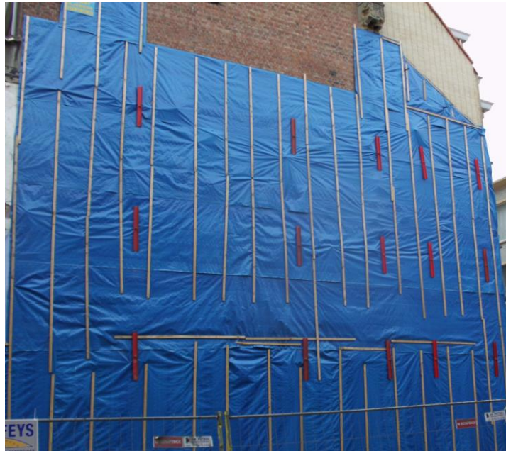
Figuur 15: Voorbeeld toepassing speldankers
