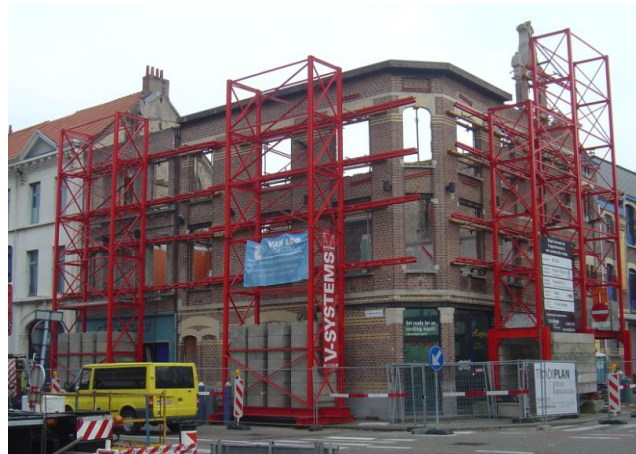
Figuur 21: Vakwerkstructuur (V-systems)
