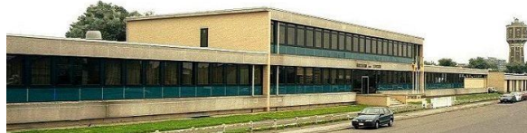
Figuur 1.1: gebouw ILVO Oostende, Ankerstraat 1
