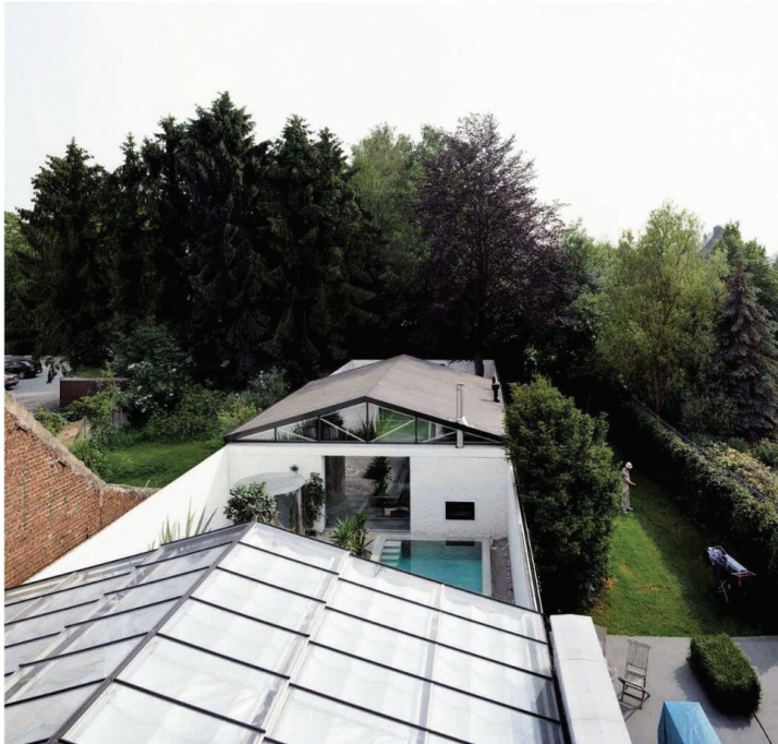
Afb 50, Weekend House Zicht vanuit gastenhuis. Merchtem, 2012
