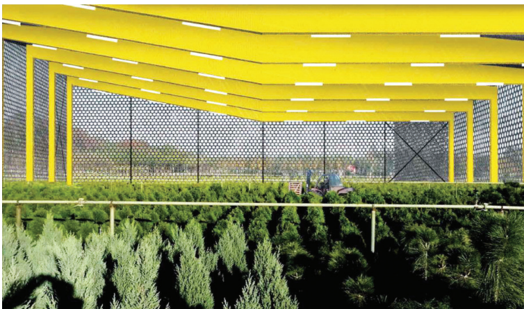
Afb 42 Drooghal Interieurbeeld Hulshout, 2012
