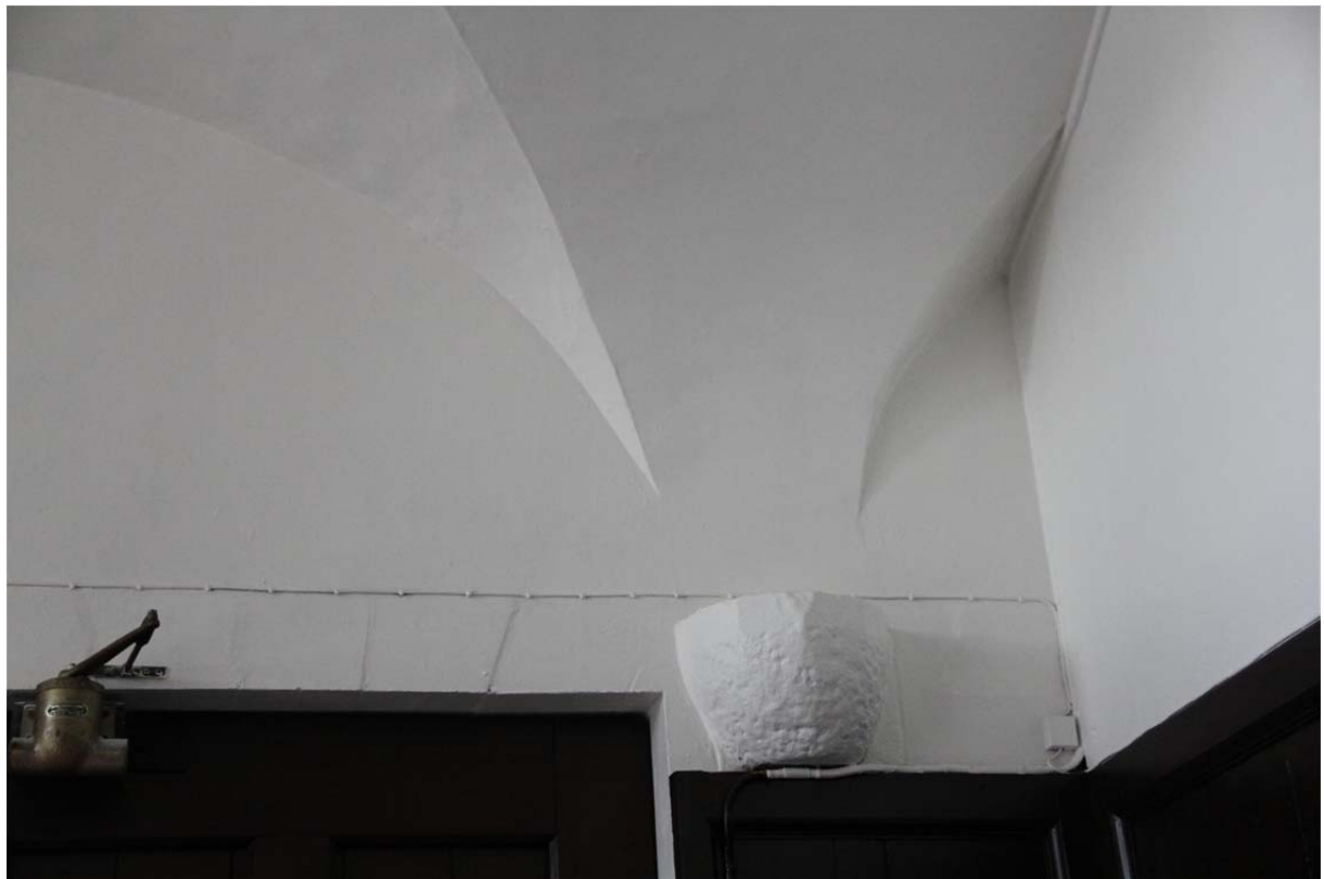
Figuur 26: dak overbrugging
