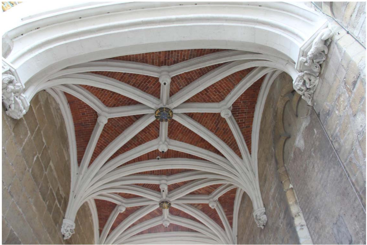
Figuur 25: draagconstructie overbrugging
