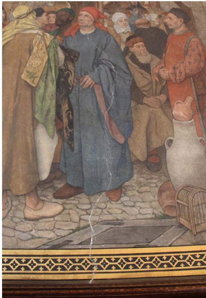
Figuur 56: linkerscheur in de Gotische Zaal
