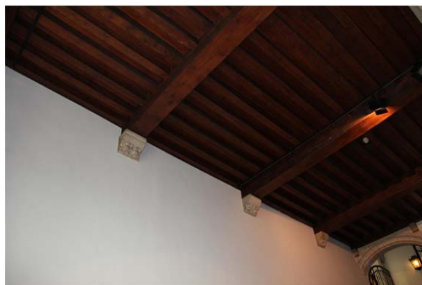
Figuur 12: draagsconstructie van tussenmuur tot oostelijke muur
