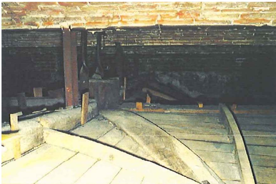
Figuur 75: onderkant gemetselde booggewelven tussenvloer 1 ste verdieping –zolder
