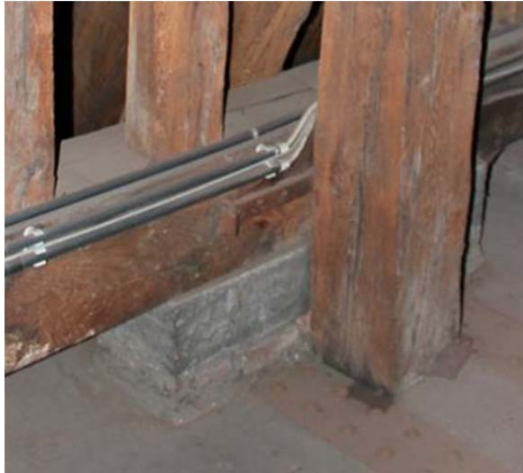
Figuur 63: steunpunt dakspant
