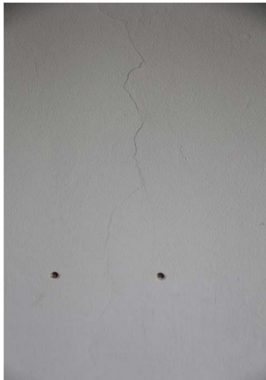
Figuur 54: detailscheur gelijkvloers
