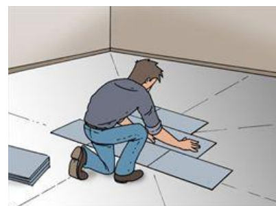
Afb. 70: tegels gelijkmatig verdelen
