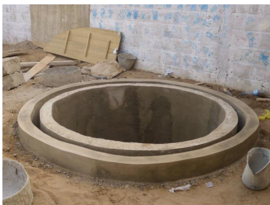
Figuur 29: Concentrische cilinders gasreservoir
