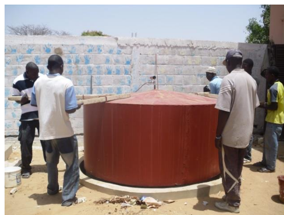
Figuur 30: Metalen cilinder gasreservoir
