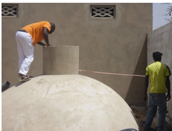
Figuur 31: Koperen gasleiding en anti-terugkeer ventiel
