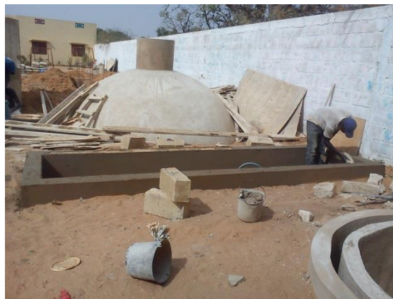
Figuur 34: Digestaatreservoir
