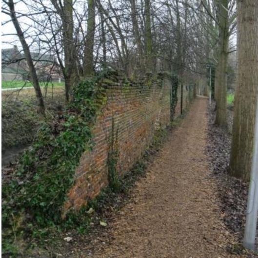
Illus. 2.4.: beguinage wall, Sint-Truiden.
