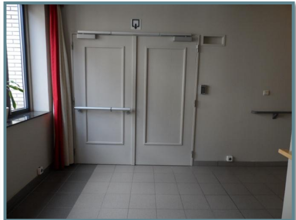
Afb. 26, Deur is gemaskeerd door in dezelfde kleur te schilderen en de leuning te laten doorlopen.
