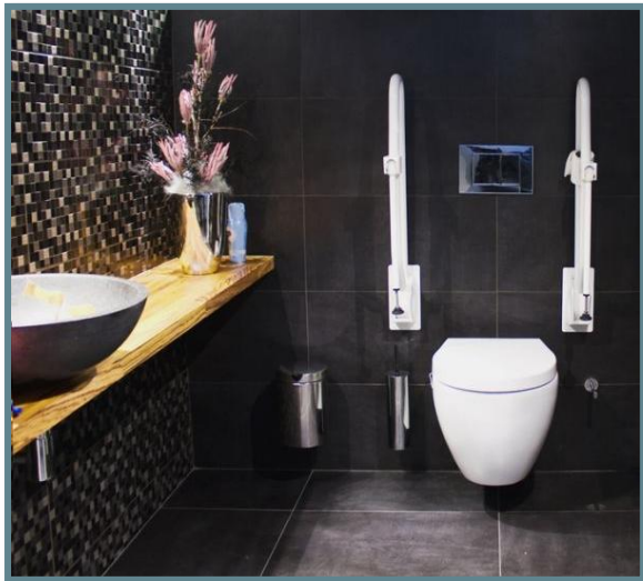
Afb. 27, Verhoogd toilet dat contrasteert met de achterwand. Achterwand en vloertegels zijn matte oppervlakte wat ook aangeraden wordt.
