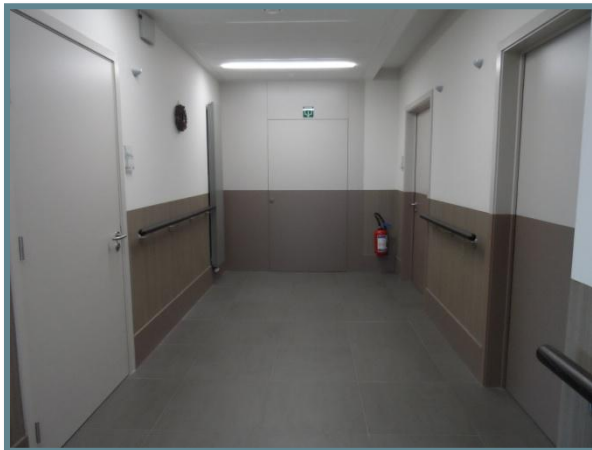
Afb. 25, Lambrisering loopt door in de deuren die niet voor de bewoners van toepassing zijn, deuren zijn gemaskeerd.
