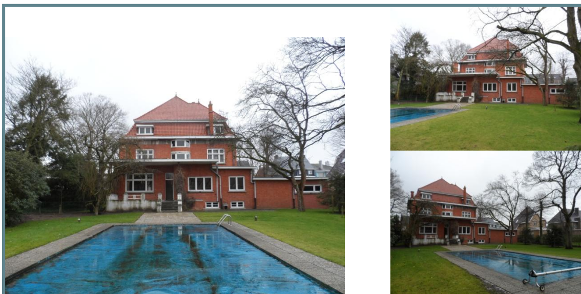
Afb.81, Achtergevel gekozen pand
