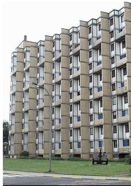
afbeelding 8 - Langsblok voor renovatie
