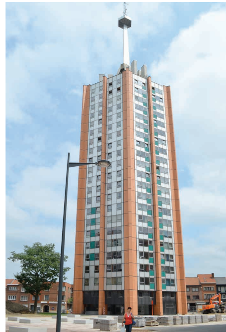
afbeelding 7 - De torens na renovatie
