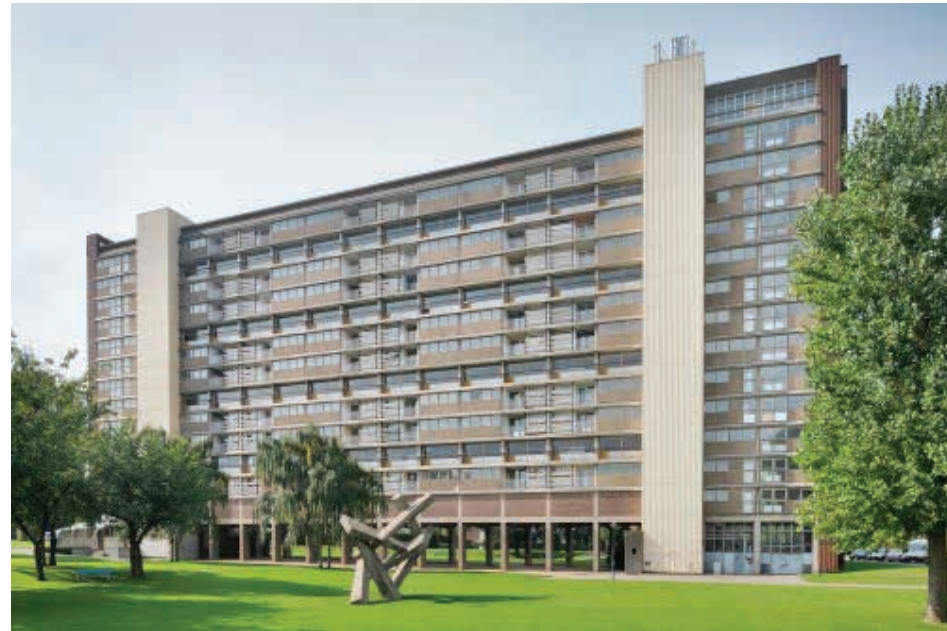
afbeelding 15 - Ieder Zijn Huis voor renovatie, Oostgevel
