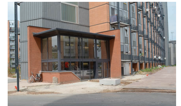
afbeelding 27 - Onthaalpaviljoen van de langsblokken - na renovatie
