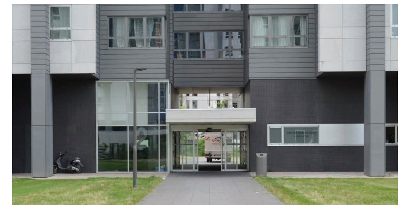
afbeelding 56 - Zicht op de inkom na renovatie, met op de eerste verdieping een nieuwe gevel zonder terrassen.
