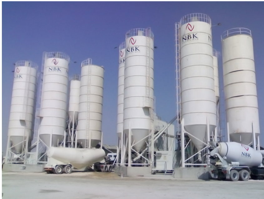
Figuur 4.40: Illustratie van enkele silo's [56].
