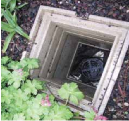
Afb.14: Controle schacht. (WTCB 2006)
