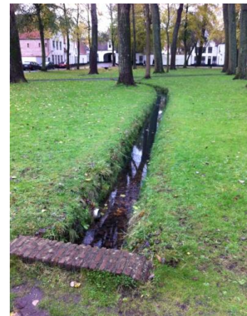
Figuur 24: Drainagegracht in Begijnhof (W. Verhelst, 14/11/2013)
