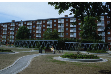
32. ACHTERGEVEL VAN PROJECT HØJE SØBORG
