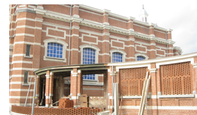
75. WERKZAAMHEDEN KAPEL EN WINTERGANGEN
