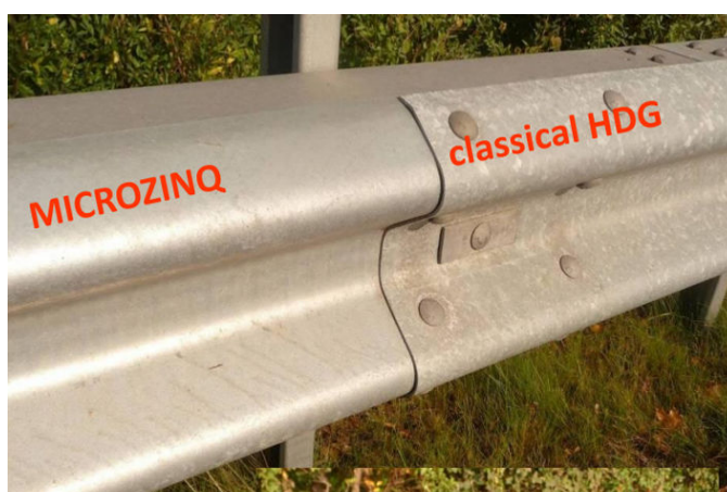
Figuur 2.6-1 Vergelijking uitzicht MicroZINQ met klassiek thermisch verzinken [61]
