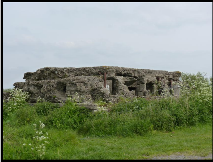
Foto 5a: vervallen Duitse bunker op enkele meters afstand van de Dodengang
