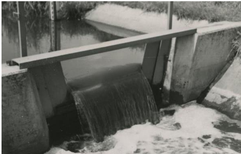
Figuur 6: Voorbeeld van een meetstuw in de Lollebeek (Nederland) [19]
