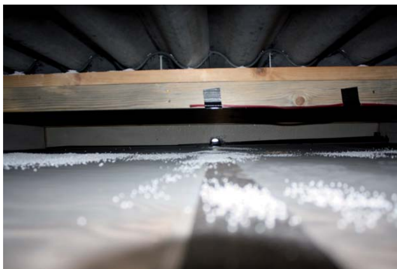
Figuur 2.31: Aanwezigheid van sneeuw in de bovenbak bij de ECOLOR
