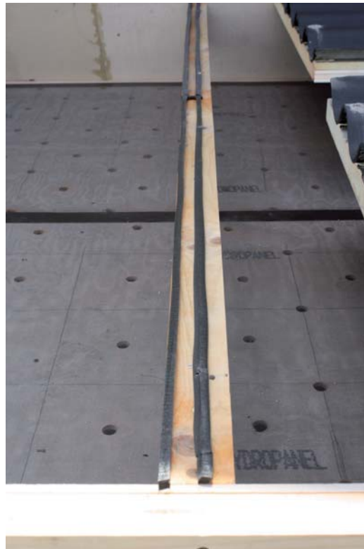
Figuur 2.43: Dubbele dichtingskit op de gording
