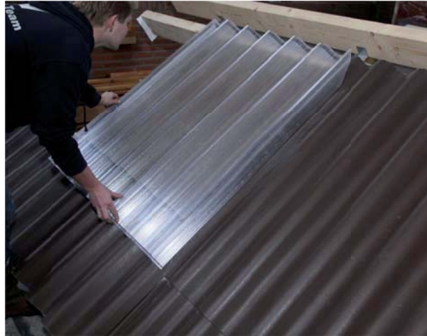
Foto 1: Plaatsing van de lichtdoorlatende golfplaat
