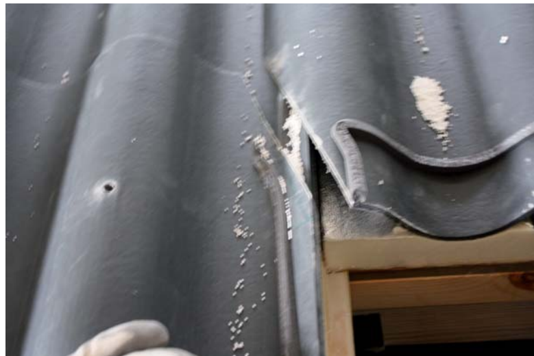
Figuur 2.38: Sneeuwophoping ter hoogte van de vier hoeken bij de ECOLOR ISO + dichtingskit
