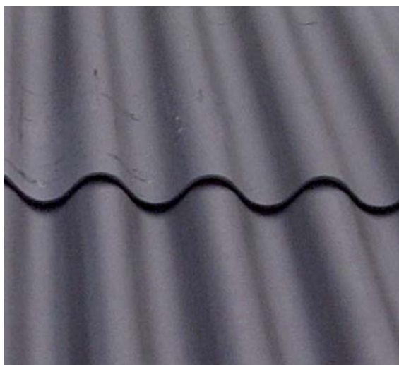
Figuur 2.17: Zowel in de top als het dal is er steeds een opening tussen twee golfplaten.
