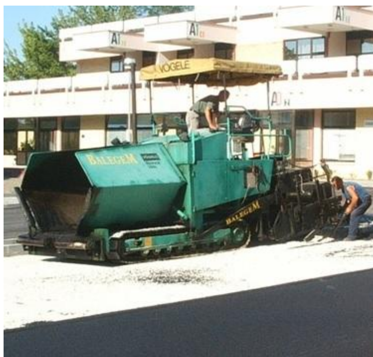
Figuur 4 Asfalteermachine firma Balegem-Gradačac.
