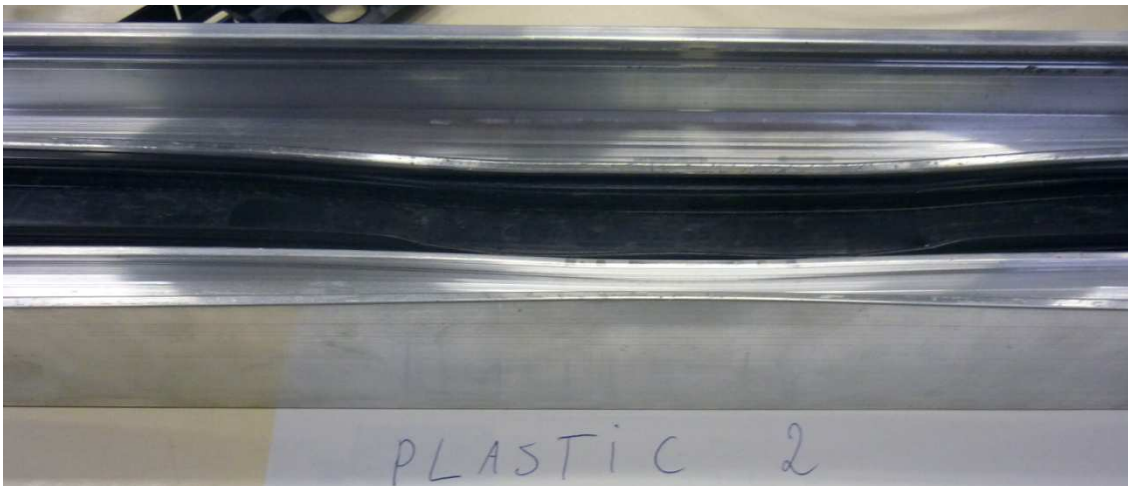
Figuur 64: Lokaal plooiën van het aluminium profiel
