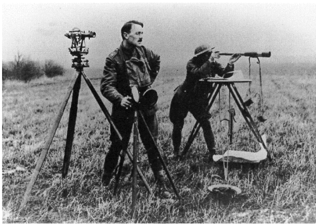
Figuur 2: Theodolietmeting aan het front (Chasseaud, 1999)
