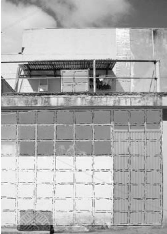
Figuur 113: Raamverhoudingen binnenin terras
