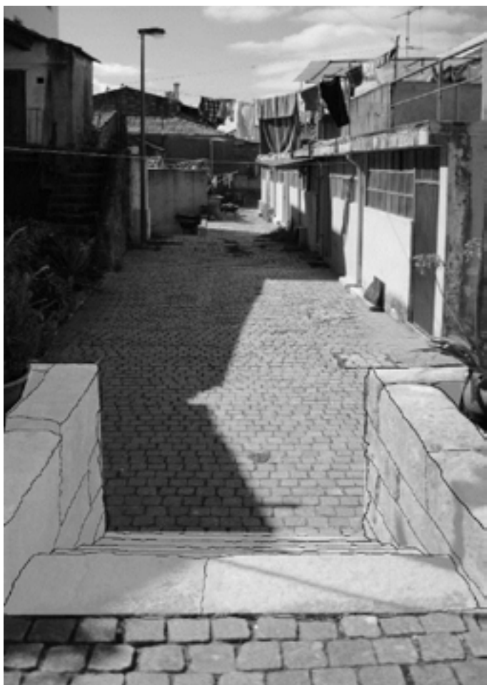
Figuur 92: Oude bestaande trappen
