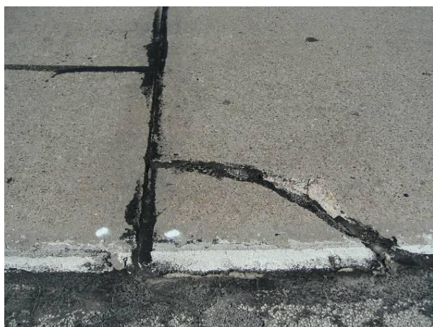
Figuur 2-13: Hoekscheur
