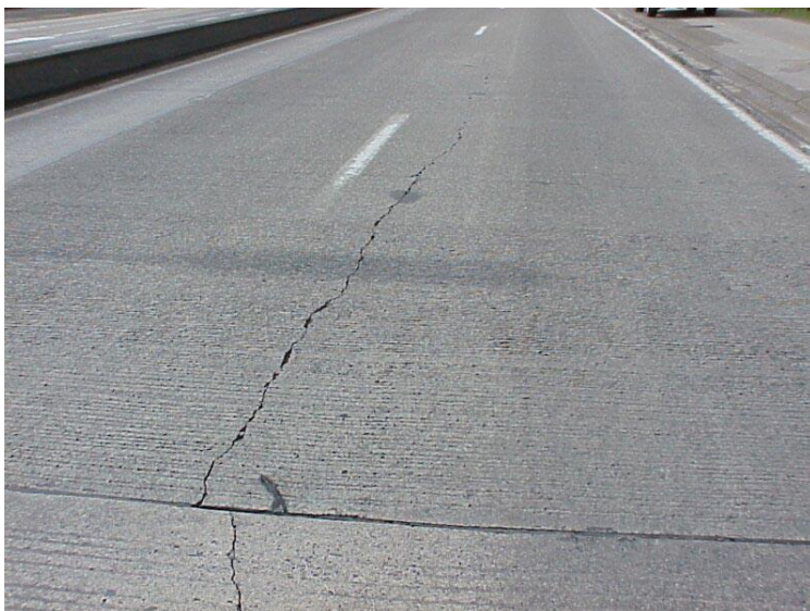
Figuur 2-11 : Langsscheur
