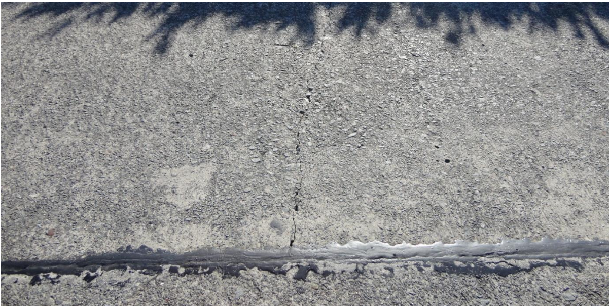
Figuur 2-9 : Dwarsscheur (Locatie Bloelandstraat Denderleeuw)
