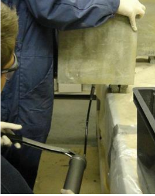
Figuur 5-35: Manier van injecteren
