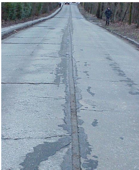
Figuur 2-18: Zijdelingse afschuiving
