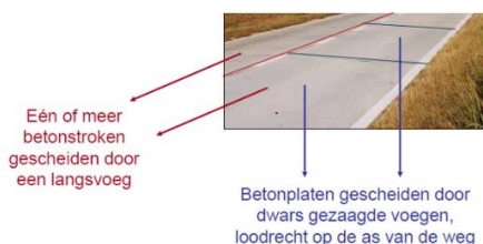
Figuur 1-4: Weergave dwars- en langsvoegen bij platenbeton
