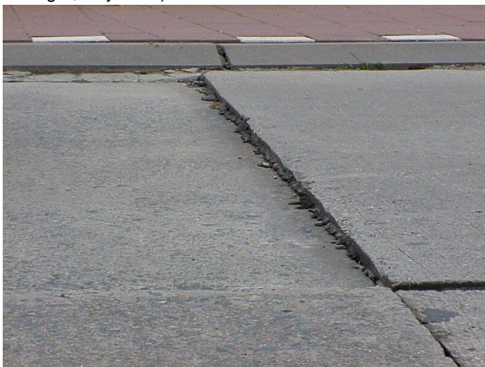
Figuur 2-17: Trapvorming
